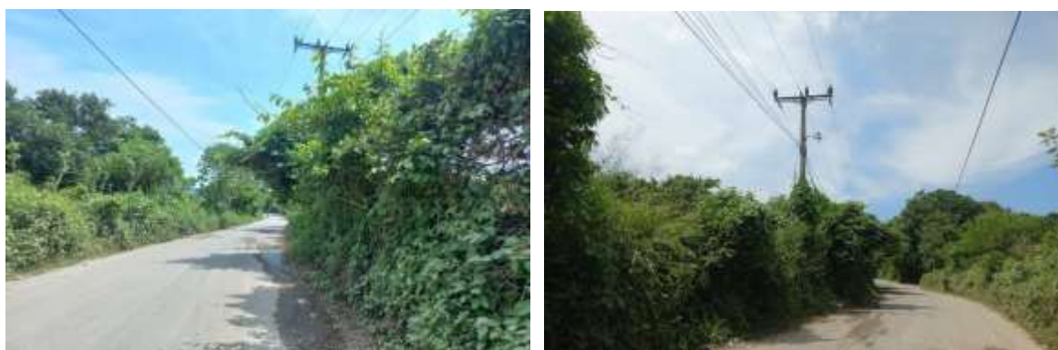
Figura 18 - Infraestructura de agua potable y energía eléctrica afectada en estacionamiento 1+400 (sobre calle antigua a Tonacatepeque), a ser reubicada y reestablecida por el proyecto. La red de agua potable, está alojada y/o enterrada en el lateral izquierdo de la vía y provee de servicio al Caserio Bola de Monte.
