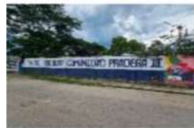
CENTRO ESCOLAR COMUNIDAD PRADERA 3, CALLE ASFALTADA
