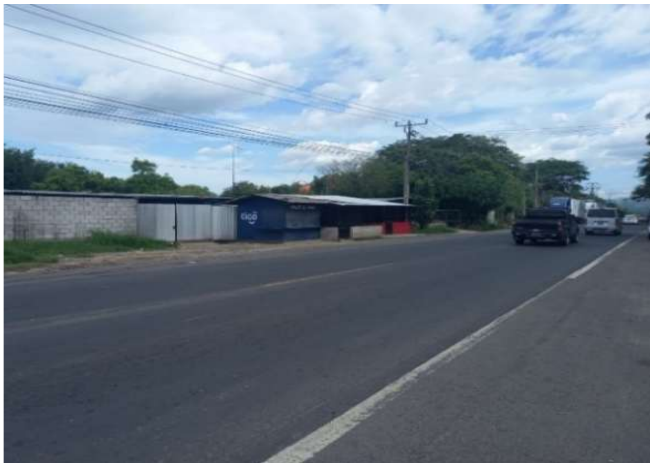
Figura 14 - Vista de zona de finalización del proyecto By Pass de Apopa, en la zona de intersección de la carretera CA04N (kilómetro 17+000) zona de emplazamiento de la intersección tipo Trébol.
