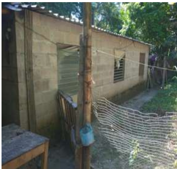
Figura 41 – Vista de una vivienda con pared de block de concreto
