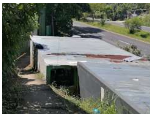
Figura 42 – Vista de una vivienda con techo/cubierta de lámina galvanizada
