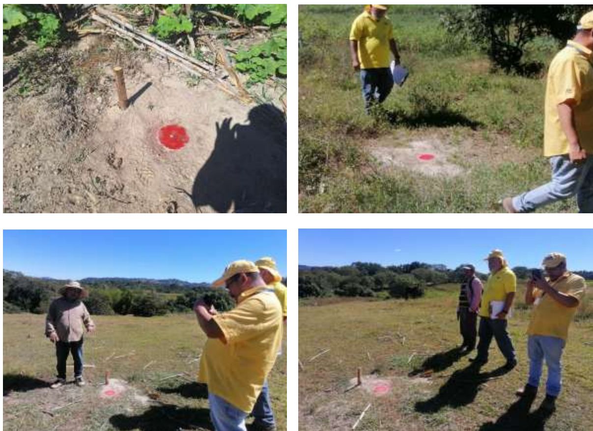
Figura 71 - Levantamiento topográfico y colocación de mojones en sitios de reasentamientos.
