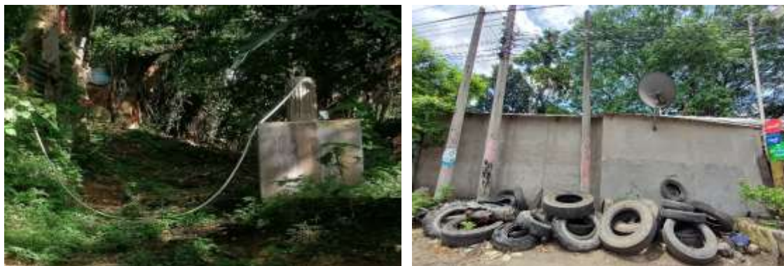
Figura 19 - Infraestructura de agua potable por cantanera y energía eléctrica afectada en Comunidad La Muralla, a ser reubicada y reestablecida por el proyecto.
